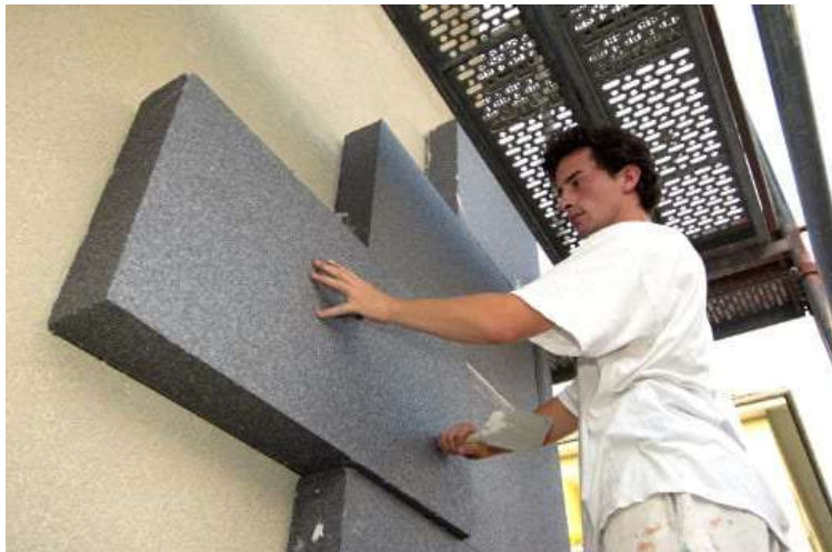
Quelle: https://www.hb-hamburg.de/fassadendaemmung-hamburg/ , abgerufen 05.01.23
