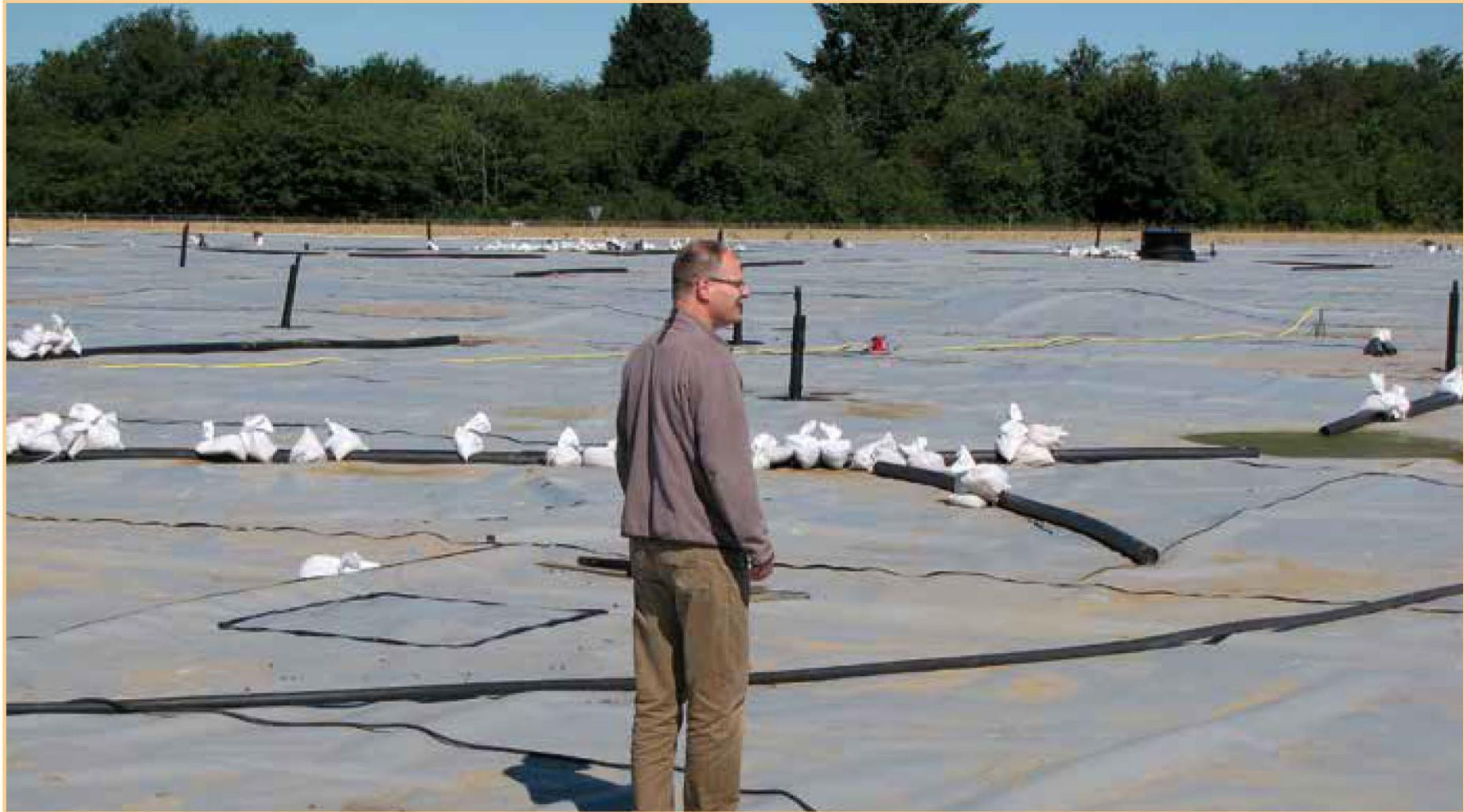
Erdbeckenspeicher in Vojens nach der Fertigstellung
